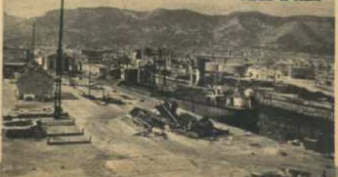
Pétrolier en bassin.
