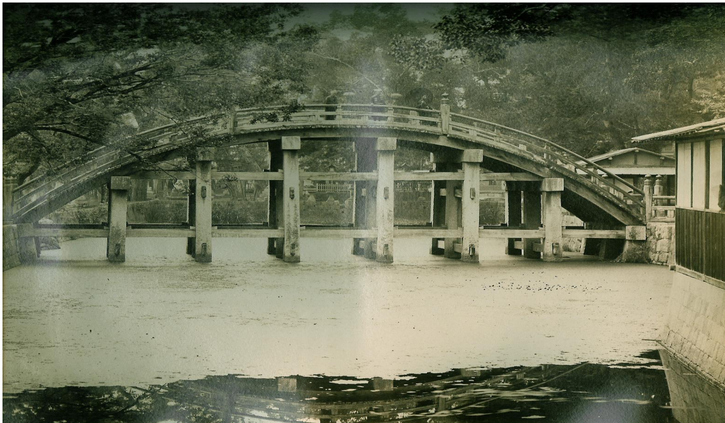
Pont de Sakai, près Osaka.
