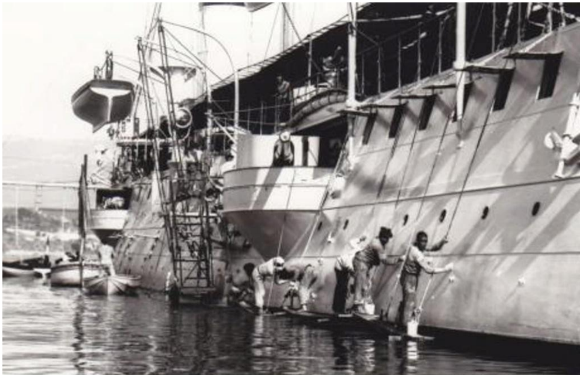
Nettoyage de la coque du Croiseur LINOIS 1894
