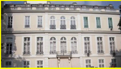
UNE VUE DE L'HÔTEL D'ESTRÉES. LE CLICHÉ DE LA PAGE PRÉCÉDENTE, DATÉ DU 18 OCTOBRE 1893, A ÉTÉ PRIS SOUS LE BALCON DE LA RÉSIDENCE DE L'AMBASSADE DE RUSSIE DE L'ÉPOQUE. DEVANT TROIS FENÊTRES DU GRAND SALON, REZ-DE-CHAUSSÉE, CÔTÉ PARC.
