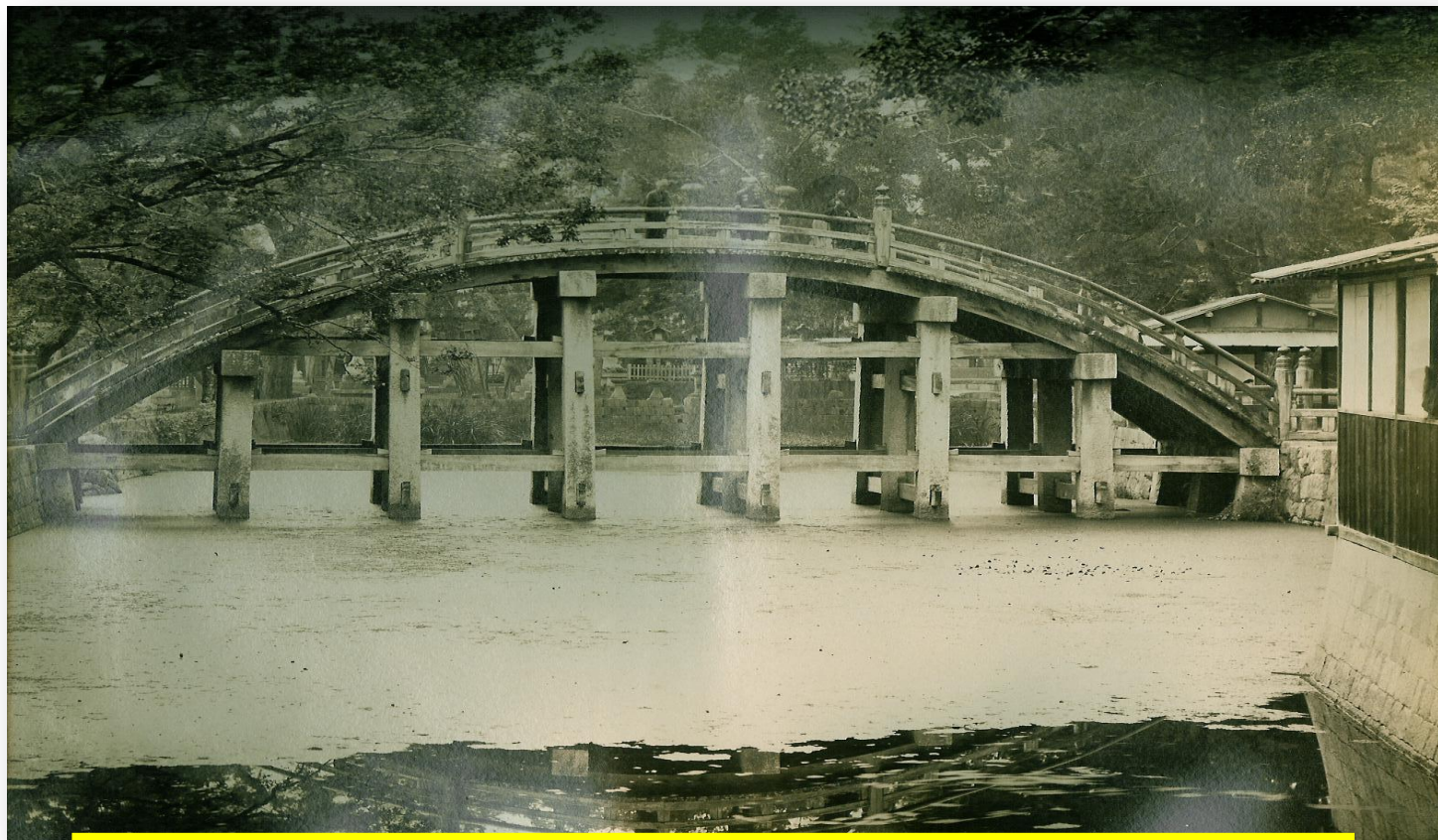
Photo du Pont de Sakai, près Osaka.
