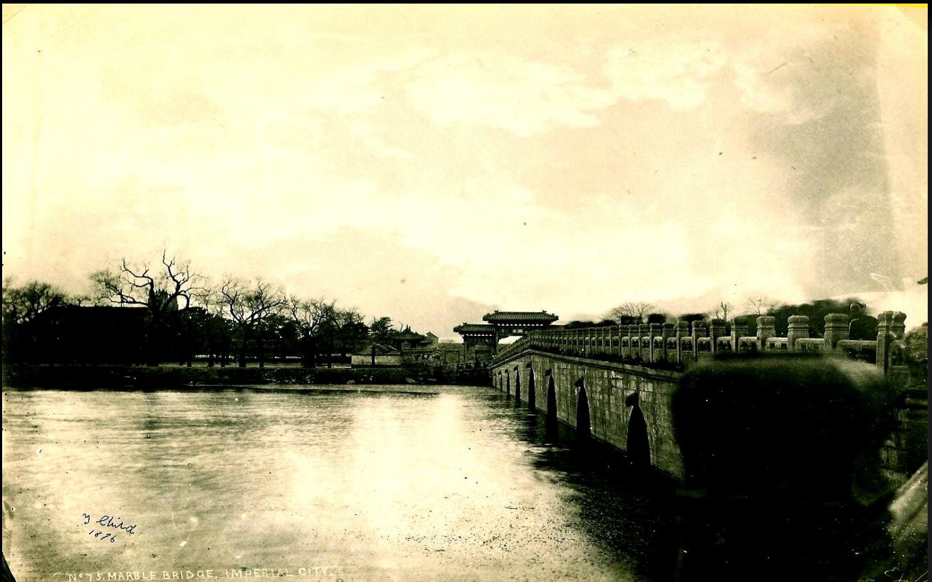
Pont de Marbre, Photo réalisée par Thomas Childe, en 1876. Annotation d'Henri Rieunier : « Ce pont a été enfermé dans le Palais Impérial peu de jours après ma visite à l'Eglise de Pé-Tang (Temple du Nord), Août 1886 ». Photographies grand format – Deux Tirages sur papier salé à partir d'un négatif papier.
