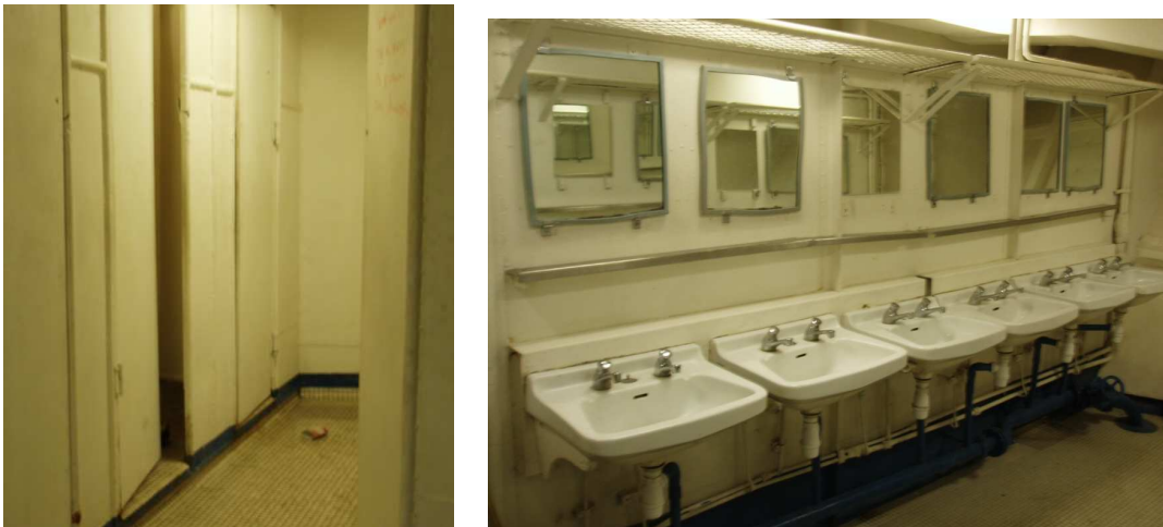
Douches et lavabos, sur l'avant, à côté du poste mécaniciens
