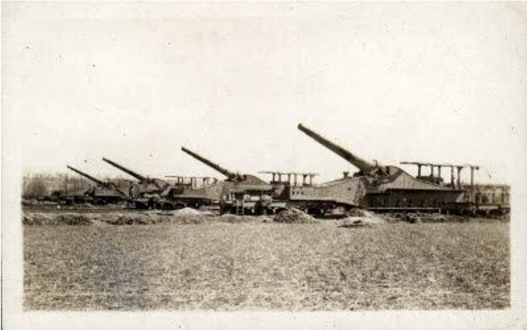
Le Langer Max de Leugenboom (batterie Pommern), dans la banlieue de Nieuport – Canons de 380 mm ( 38-cm-Geschütz ), obus de 800 kg. Tirent contre le front terrestre et Dunkerque. Mis en place en Flandre à partir du printemps 1917.
